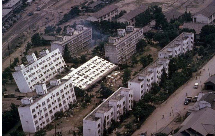
Terremoto de Niigata, Japón (26 de Junio). Sismo de 7.4 de magnitud, 26 muertes, destruyó 3018 viviendas y dejó con moderados o severos daños otras 9750 construcciones en Niigata. La fotografía muestra los daños ocasionados a varios edificios de apartamentos por la licuefacción del suelo y por el pobre comportamiento de las fundaciones.
