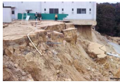
Terremoto de Kobe (1995). Cerca de 30 personas murieron por el deslizamiento.
