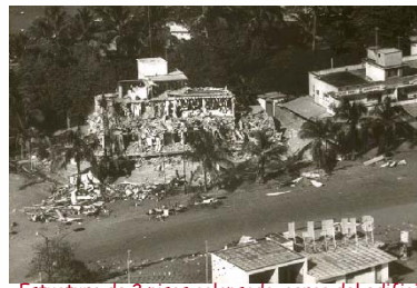
Estructura de 2 pisos colapsada, cerca del edificio Laguna Beach en Caraballeda.
