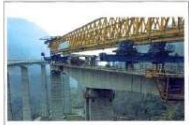
Construcción de un viaducto
