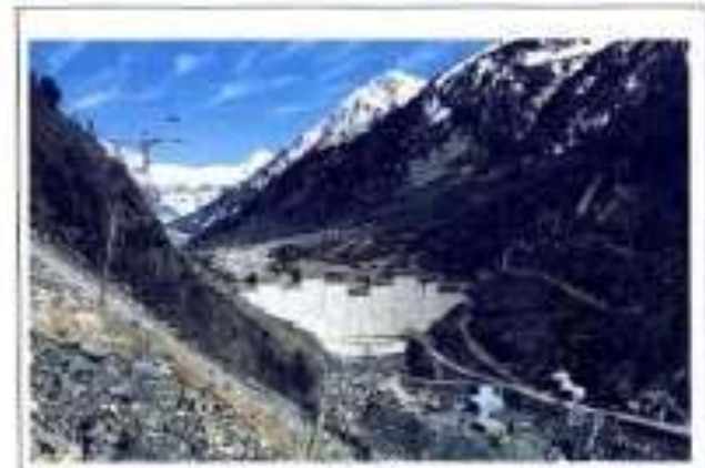
Construcción de una presa
