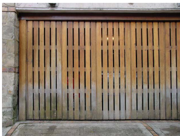
Degradación de la madera por efecto de la intemperie
